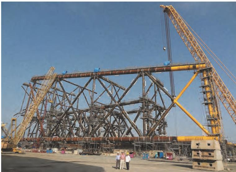
***Рис. 5. Строительство нефтегазодобывающей платформы на производственной базе СП «Вьетсовпетро» в Вунгтау (фото автора 19.01.15)***
